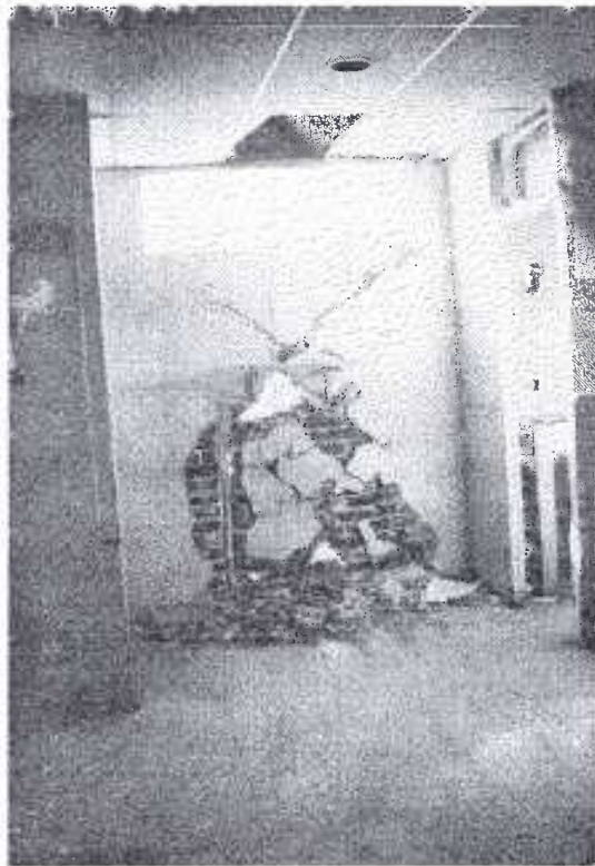
FOTO N° 23: Vista interior de la F. 22.
